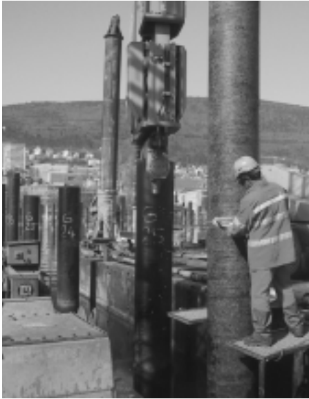
Links: «Pre-cycling» am Beispiel der Stützpfeiler der Artepilge in Neuchâtel: Schon gebraucht gekauft, nach dem Rückbau anderswo wiederverwendet. Rechts: Die Baumaschinen an der Expo 02 waren mit Russpartikelfiltern ausgerüstet (Fotos: A. Stuber).
