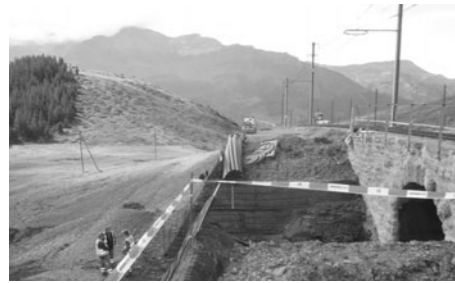
Geländeanpassungen für den neuen Damm (Foto: R. Stämpfli).
